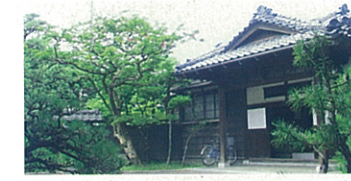
27 旧日本銀行新潟支店長宅(砂丘館) 西大畑町 ちょっと昔懐かしい感じの建物と広々とした庭がすばらしいです。
