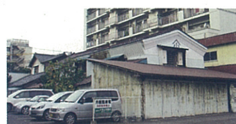
53 Kさんの蔵 上大川前通8 新潟にもまだまだ土蔵が残っていますが、その中でもここが一番大きいと思います。
