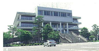
21 旧白根市庁舎 白根 1階からスロープで2階に登るアプローチや、中央部に螺旋階段を備えるなど、珍しい構成の建物です。
