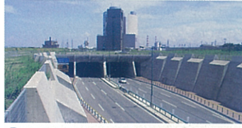
70 新潟みなとトンネル 全国的に見ても海底トンネルは少ないと思います。
