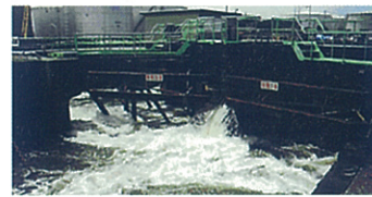
71 山の下閘門排水機場 櫻町 パナマ運河と同じ仕組みで迫力満点です。
