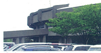
42 鳥屋野野球場 女池南3 前面にアーム状に伸び出したスロープや各種の造作が美しい施設です。
