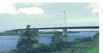
10 ときめき橋 新潟市内唯一の斜張橋で、特に夕暮れ時が美しいです。
