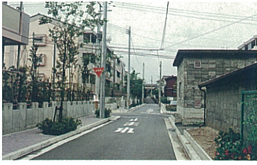
107/小針市営第1団地 静かな住宅街の一角に市営小針住宅が3棟建設されました。色調の穏やかさ、団地内に配した小公園や切妻の屋根など、周辺に近親感を与えています。
