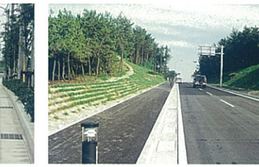
111/市道 青山幹線 新しくできた連絡路、国道402号へ通じる道、とてもきれいに整備されています。
