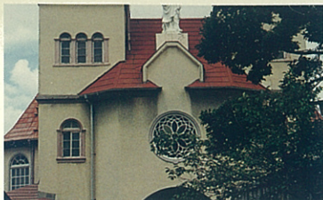
19/新潟カトリック教会聖堂の双塔 昭和の初期に建立 文化的価値があり、異人地の面影を残しており、結婚式や修学旅行の見学でも活躍しています。
