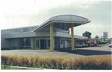
106/サンバースト にいがた 郊外にあるこの建物は、障害者の「明るく安心して気持ちよく働ける施設」と位置づけられ、オープン形態で外部環境、内部環境とも計画しています。
