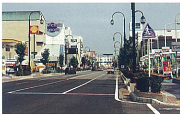
80/和合線の電線埋設化工事を実施した区間 (キャブ工事及び関連道路) 電線を埋設し、すっきりした道路の両側の 歩道が、「海辺の街にいかた」の渾をイメージ したタイルの配列で美しく、海岸を歩いている 気分です。
