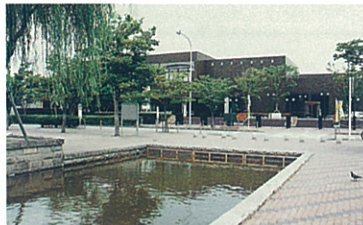
21/新潟市美術館 濃い茶色の外壁と煉瓦調の歩道が木々の緑にとっても良く調和し、美術館としての風格と安らぎを同時に感じさせる建物です。
