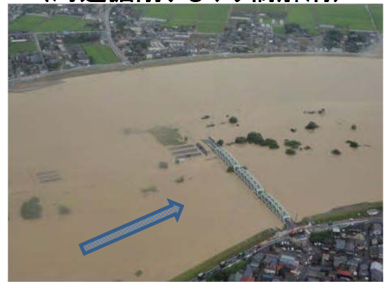
小須戸橋付近の出水状況(平成23年7月30日撮影)
