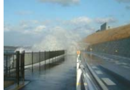
市道への越波状況
