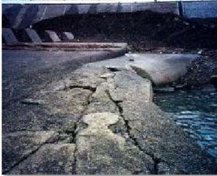
第二床固 水叩き部のひび割れ状況
