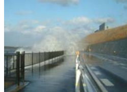
市道への越波状況
