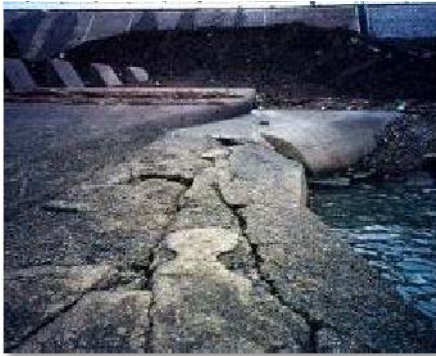
第二床固 水叩き部のひび割れ状況
