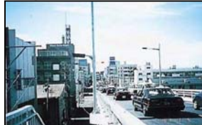
東跨線橋の現状
