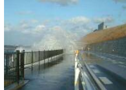
市道への越波状況
