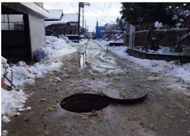
写真①：新潟市西区善久地内 (液状化によりマンホール内の土砂が堆積)
