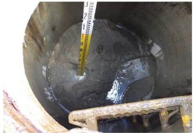
写真①：新潟市西区善久地内 (液状化によりマンホール内の土砂が堆積)
