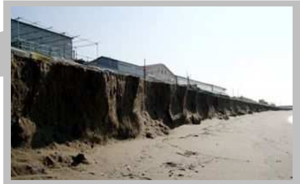
関屋浜海水浴場の侵食状況(平成18年9月)
