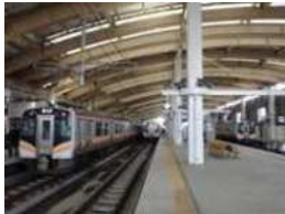
高架駅の様子
