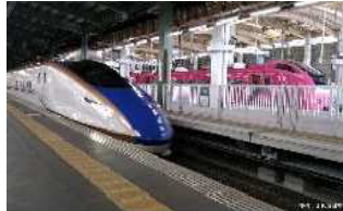
新幹線と在来線の「乗り換えホーム」
