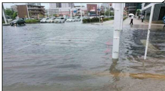
[浸水被害状況] 撮影地:新潟駅南口付近 H26年7月9日 時間最大降雨30.5mm/h
