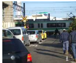
除却前の踏切
