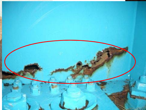
主桁の腐食による断面欠損 (通行止めを実施した橋梁)
