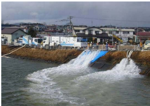
3・11大震災における排水ポンプ車稼働状況
