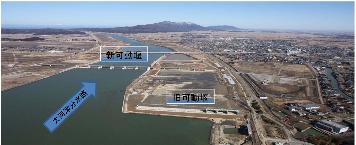
平成23年11月に新可動堰への通水が行われ、流下能力の向上が図られた。
