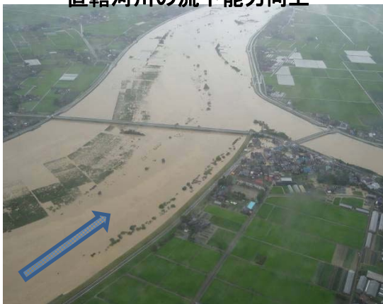
平成23年7月豪雨時、計画高水位を超えた 信濃川保明新田観測所付近
