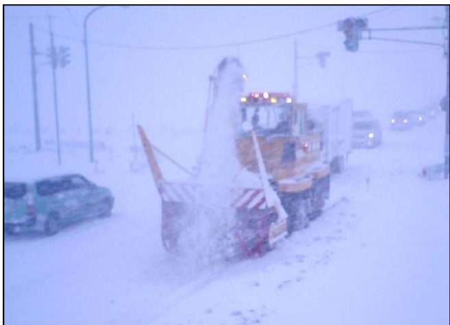
○ロータリーによる拡幅作業
