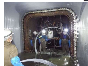
下水道管渠の改築工事
