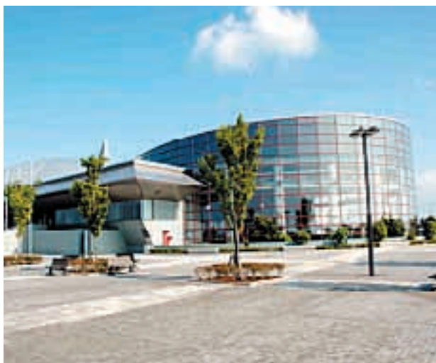
亀田総合体育館
