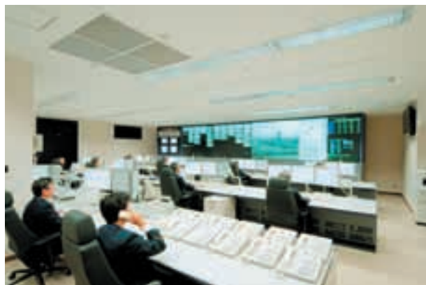
消防局指令管制施設
