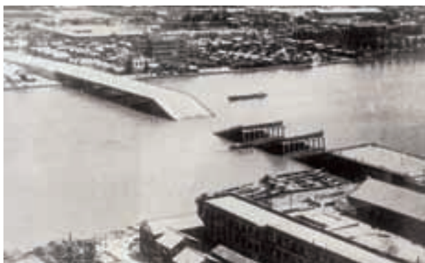
新潟地震で落下した昭和大橋
