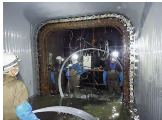
下水道管渠の改築工事
