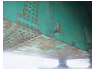
主桁の腐食
