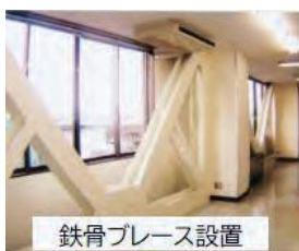
下水処理場の耐震化
