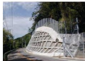
法面对策工事（施工後）
