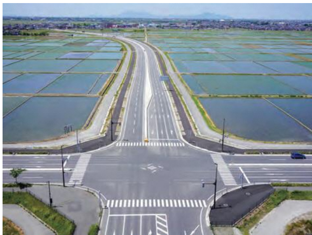
新潟中央環状道路 横越バイパス
