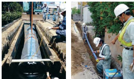
耐震管への更新工事
