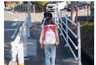
通学路の防護柵設置
