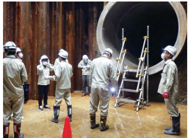
雨水貯留施設の整備
