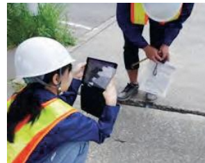
タブレットを用いた点検
