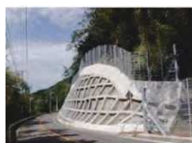
法面対策工事（施工後）
