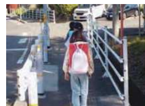
通学路の防護柵設置
