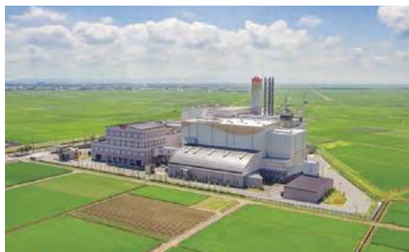
新田清掃センター（ごみ焼却発電所）
