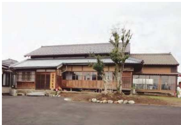
空き家を改修して「地域の茶の間」として活用
