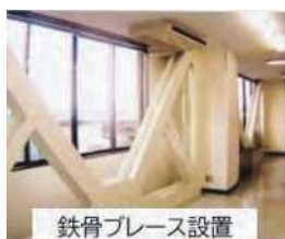
下水処理場の耐震化
