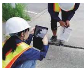
タブレットを用いた点検
