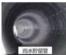
浸水対策施設の整備
