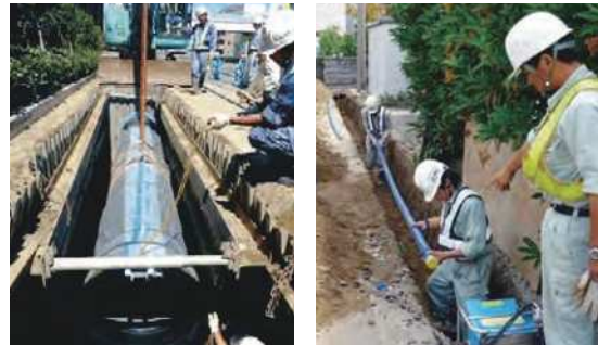
耐震管への更新工事
