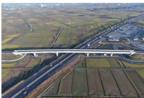
新潟中央環状道路 *2 （くろさき茶豆大橋）
