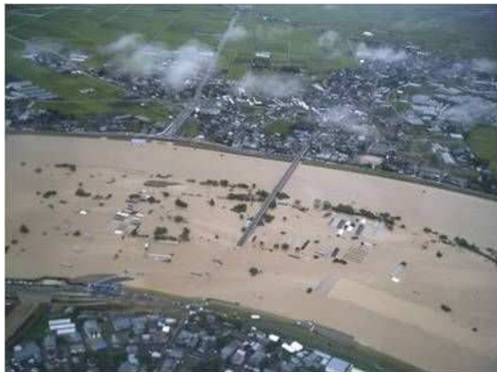
【冠水した旧臼井橋】
