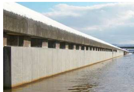
鋼矢板水路の腐食対策
