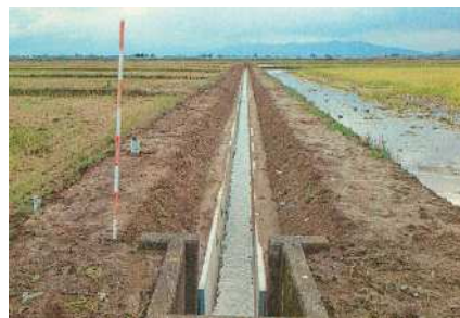
土水路から排水フリウムへの更新
