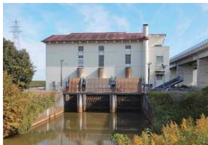
洪水被害から農地や市街地を守る 本所排水機場
