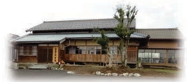
空き家を「地域の茶の間」に改修した例
