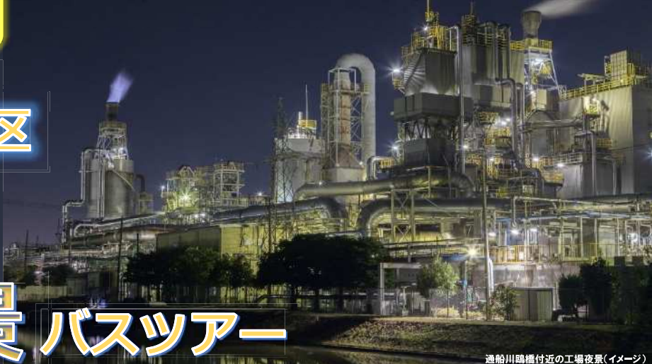
通船川鷗橋付近の工場夜景(イメージ)
