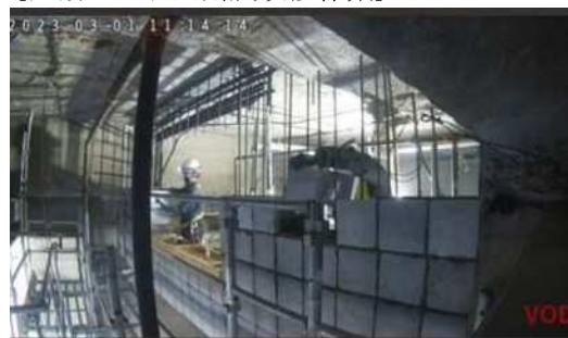
[西堀ローサ内耐震改修作業]
