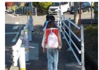
通学路の防護柵設置
