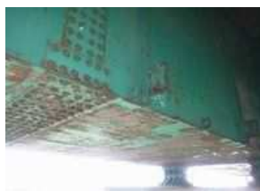
主桁の腐食
