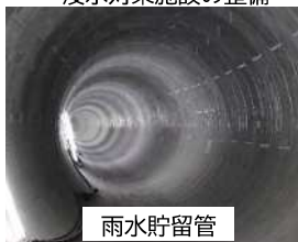
浸水対策施設の整備
