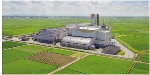
新田清掃センター(ごみ焼却発電所)
