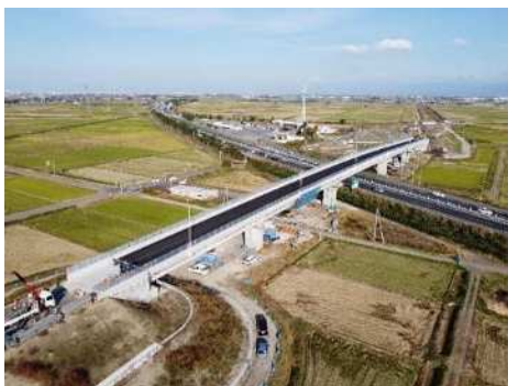
新潟中央環状道路(くろさき茶豆大橋)
