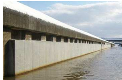
鋼矢板水路の腐食対策
