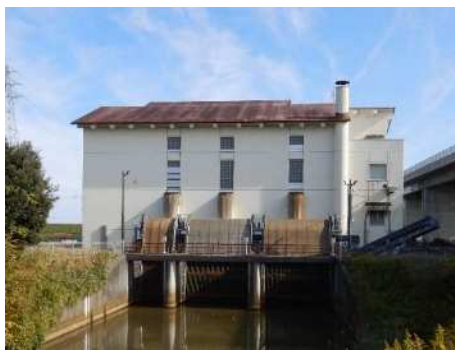
32 洪水被害から農地や市街地を守る 33 本所排水機場 34
