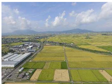
大区画ほ場（西蒲区山島地区） 農地中間管理機構関連農地整備事業
