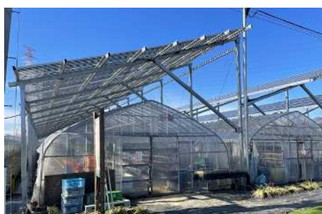
ハウス上部の太陽光パネル
