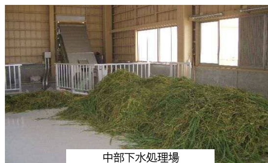
【刈草受入れ状況】
