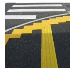
点字誘導ブロック
