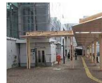
エレベーター及びシェルター(上屋)
