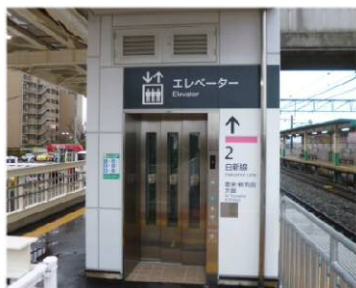
エレベーター設置(JR東新澁駅)
