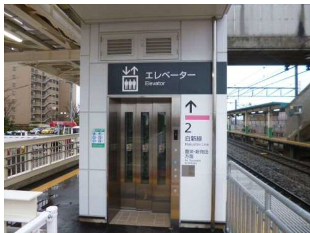
エレベーター設置（JR東新大塚駅）
