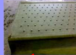
滑り止め用突起の設置
