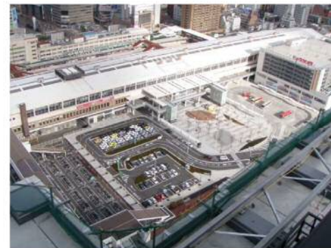
新潟駅南口広場 (平成 21 年度第一期工事終了)
