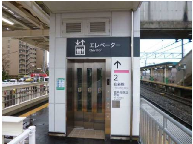
エレベーター設置（JR東新大塚駅）
