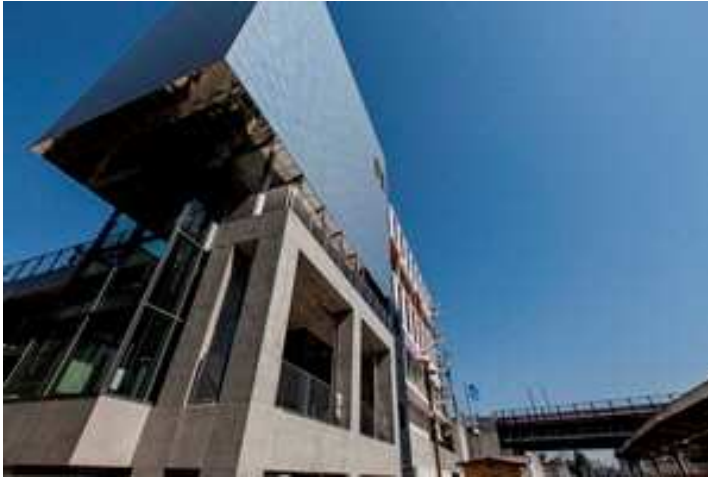
上空に浮かべた機械式駐輪機の格納庫
