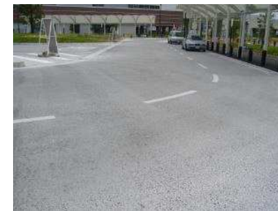
半たわみ舗装
