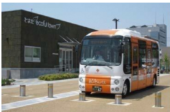
ライジングボラードによる車両の進入制限 (愛知県豊田市)
