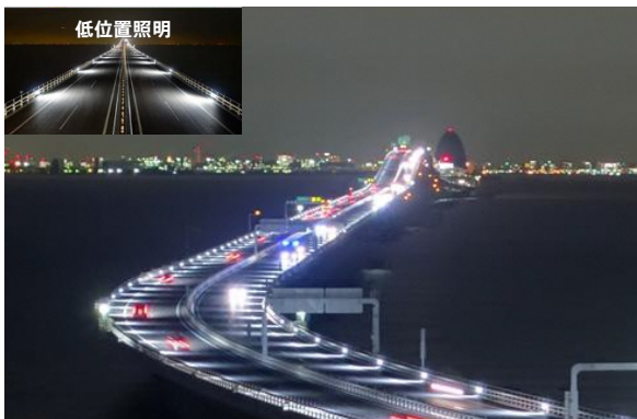
低位置に設置することで施工・管理が容易な照明 (東京湾アクアライン (神奈川県川崎市～千葉県木更津市))
