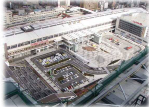
新潟駅南口広場 (H21第1期工事終了)
