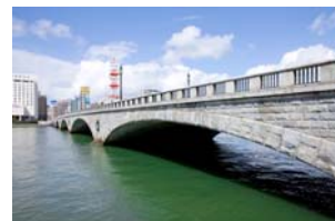
萬代橋（表面を御影石で仕上げた六連アーチの橋梁）
