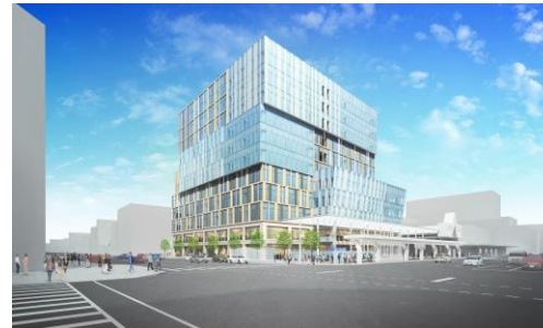
古町ルフル（建設中）
