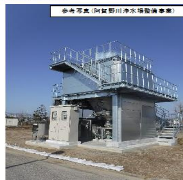
接触時間確保のため、新たに取水場に活性炭注入設備を設置
