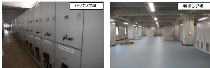
旧ポンプ場にある受変電設備を機能停止とし、新ポンプ場に新設。 老朽化した各計装機器の更新。
