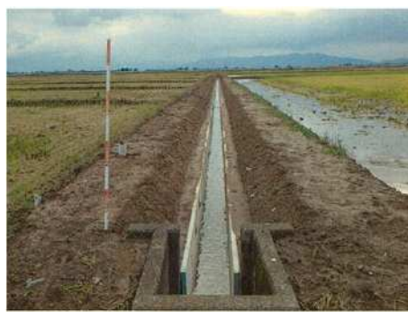
土水路から排水フリームへの更新
