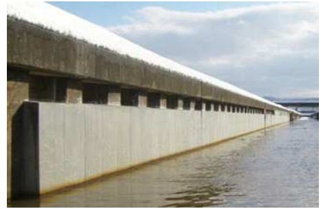
鋼矢板水路の腐食対策
