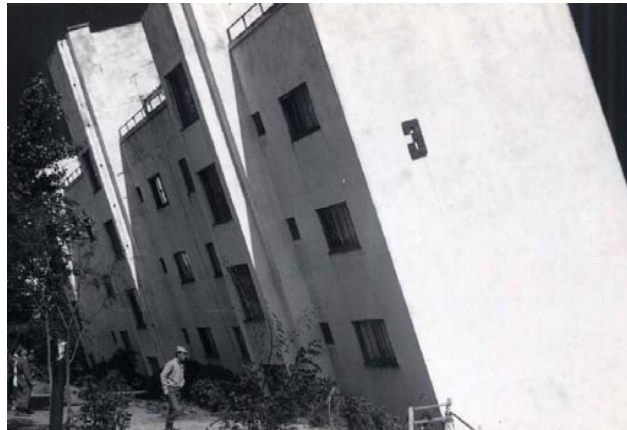
地盤の液状化により傾いた建物(昭和 39 年新潟地震 新潟市川岸町県営アパート)
