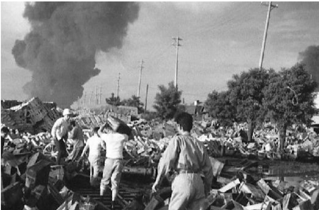
火災による被害（昭和 39 年新潟地震）
