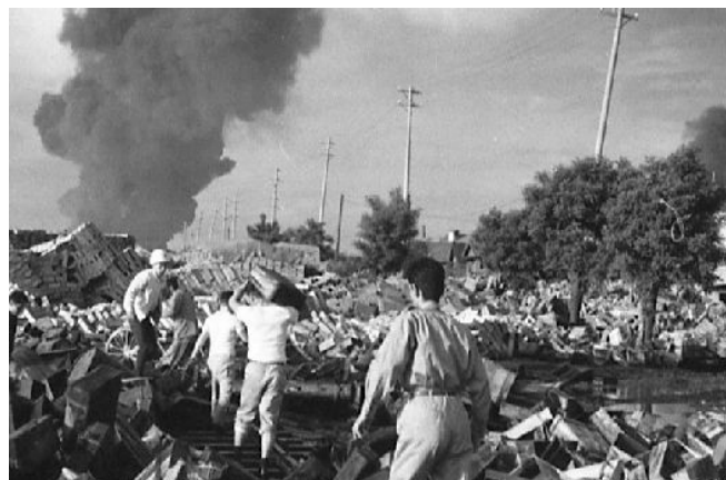
火災による被害(昭和 39 年新潟地震)
