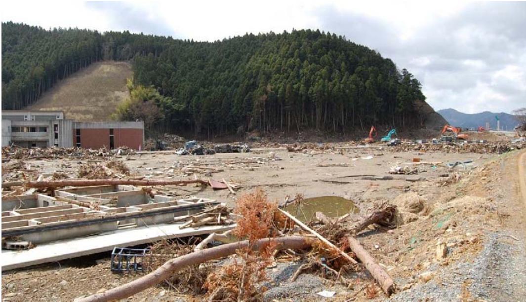
多くの児童が犠牲となった大川小校舎と新北上大橋取付部の被災状況(平成 23 年東日本大震災) 出典: (財)消防科学総合センター
