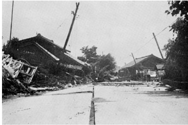
地震のゆれによる建物倒壊(昭和 39 年新潟地震 小針地区)
