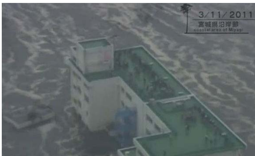
津波が到達した避難ビルの様子(平成 23 年東日本大震災 宮城県沿岸部) 陸上自衛隊東北方面隊提供映像より
