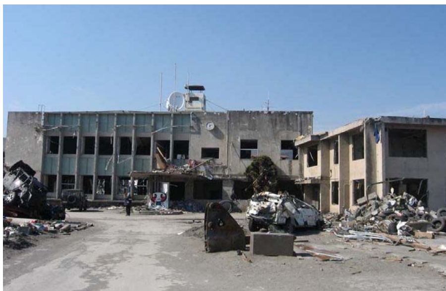
津波にのみ込まれた大槌町役場(平成 23 年東日本大震災)
