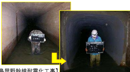
【鳥屋野幹線耐震化工事】
