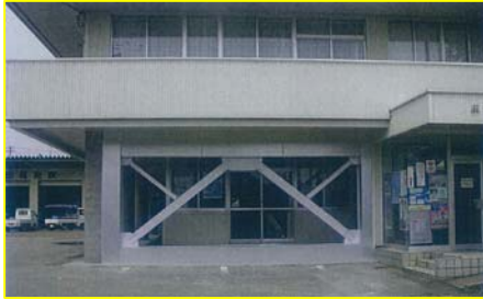
【庄瀬地域生活センター・補強工事】
