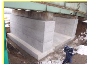
【小須戸橋・橋脚補強工事】
