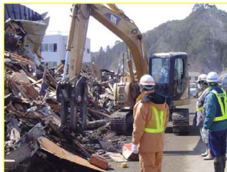
【啓開作業の様子（宮古市田老町地区）】
