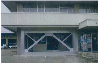
【庄瀬地域生活センター・補強工事の例】
