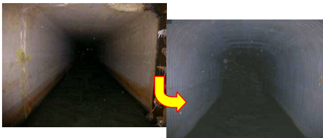
【鳥屋野幹線耐震化工事(プラスチック材による管渠内面被覆)】
