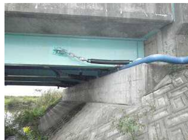
【高橋(北区)・耐震対策工事の例】
