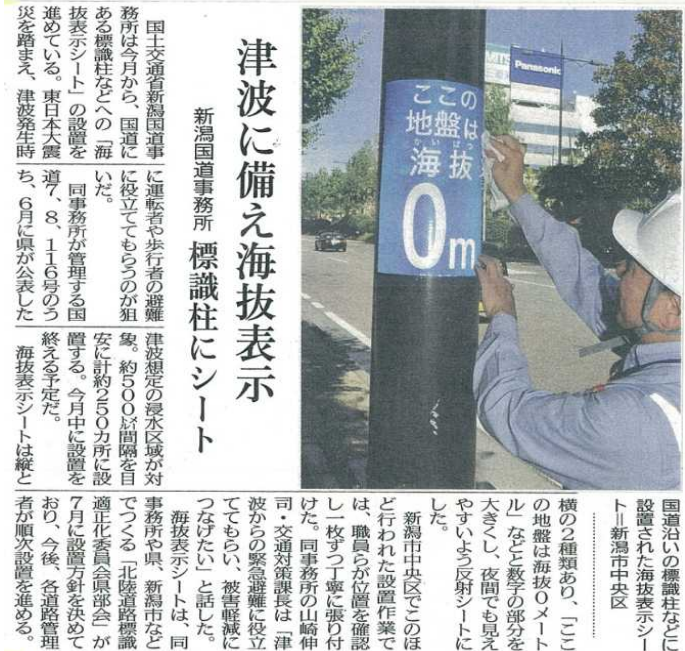
海拔表示シート 設置作業状況
