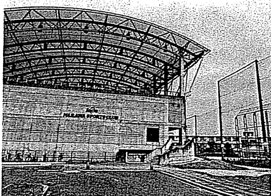
●「成岩ウイング」の愛称のソシオ成岩スポーツクラブのクラブハウス。成岩中学校の体育施設、成岩地区の社会体育施設の共用型建物である。
