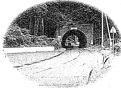
〈R402号下山トンネル〉
