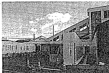
荻川駅西口広場の整備工事 (エレベーターは完成済み)
