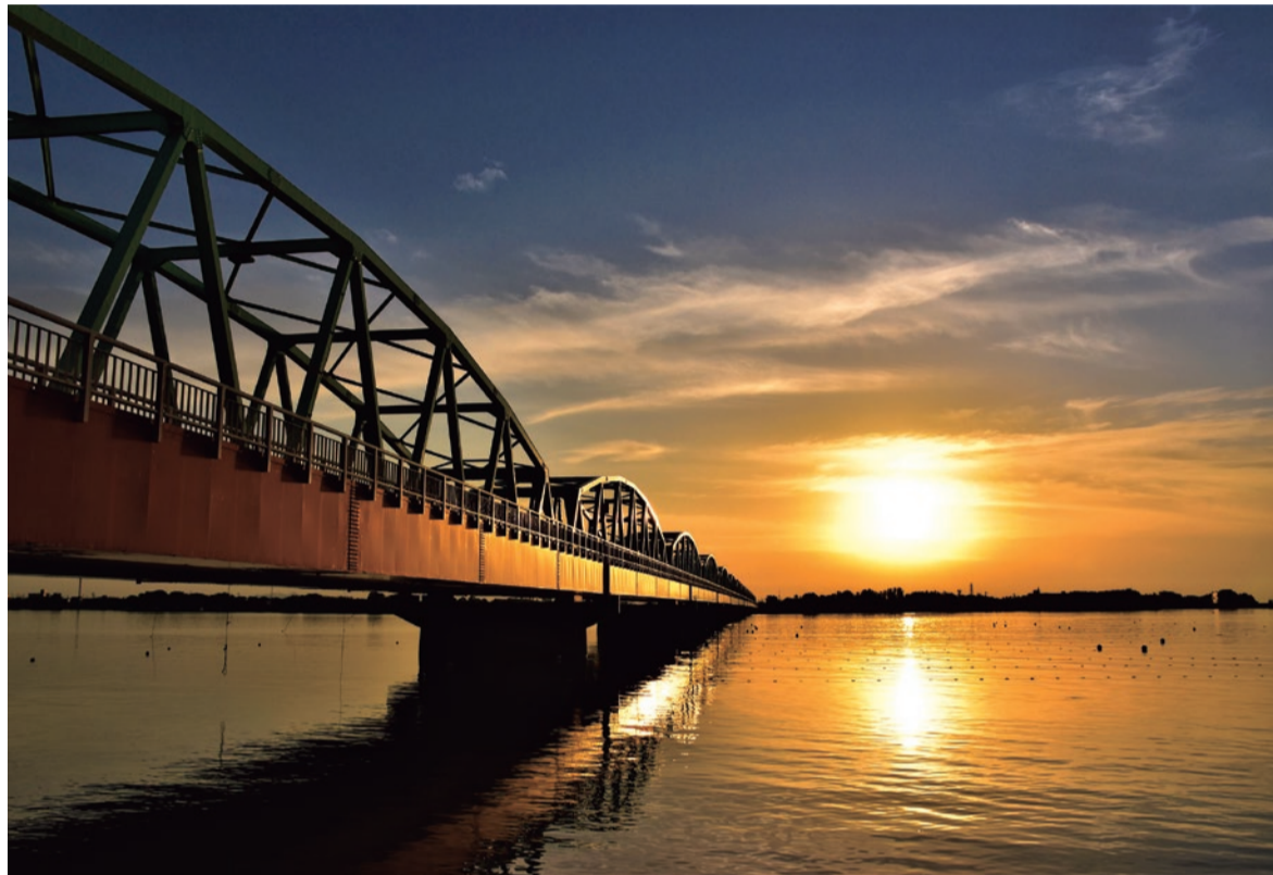
北区と東区を結ぶ阿賀野川に架かる松浜橋は、初代の木橋が1943年に架橋され、3代目となる現在の橋梁は1964年に竣工したものです。
