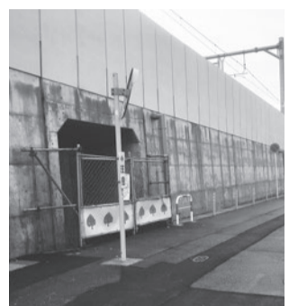
高架下に整備中の区画道路入口付近(西跨線橋から約250m東側)
