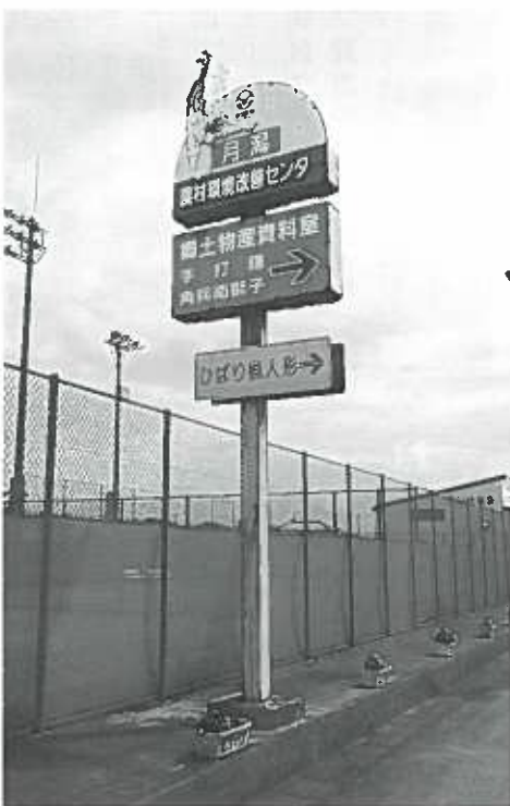
▲ 腐食の進んだ看板
