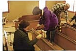
奉仕作業(修繕)
