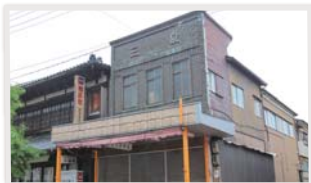
建物の外壁が看板となっている看板建築
