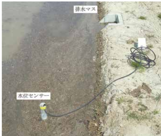
写真 3.1 設置した水位計
